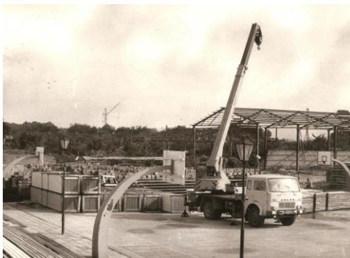
Plac budowy sali gimnastycznej
