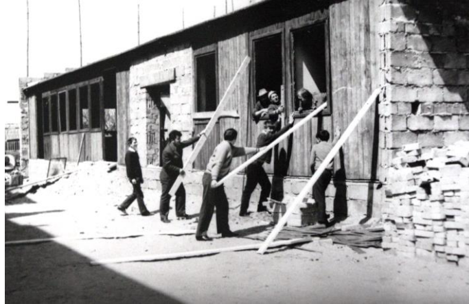
Dyrektor Jan Wilkoś i kierownik Jan Kiciński na placu budowy
